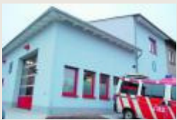
In vollem Glanz erstrahlt das von Gemeinde und Kameraden erschaffene neue Gerätehaus. Bild:
